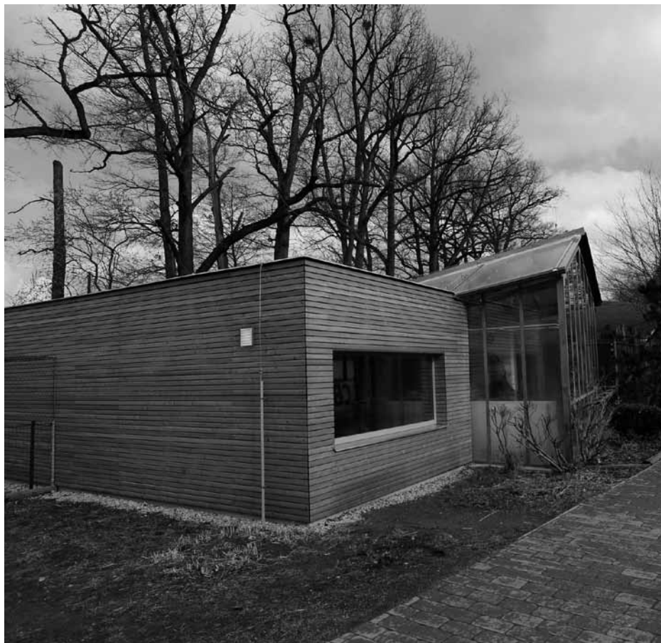
Přístavba zimoviště plameňáků
