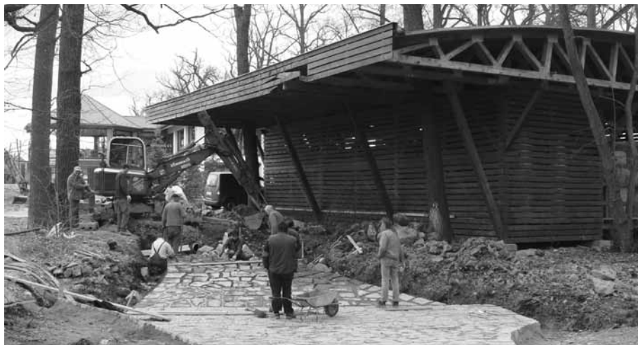
výstavba brodu ve výběhů losů evropských
