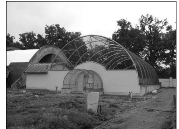
V červnu byla dokončena stavební část průchozí voliéry, určené pro naše lesní ptactvo - foto R. Kössl
