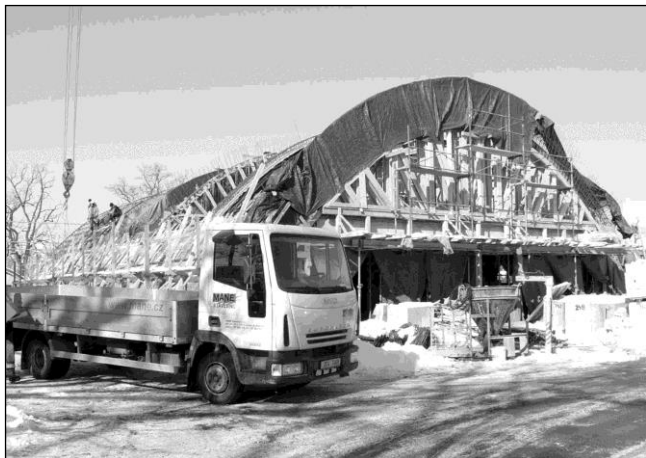
Stavba centra ekologické výchovy v areálu nové části Zoo Ohrada
