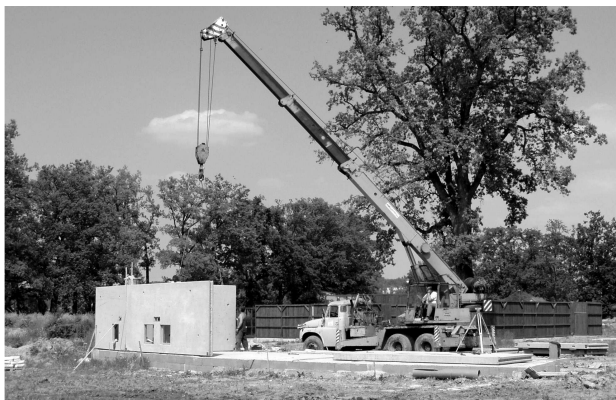
Montáž objektu vnitřních ubikací medvědů a tygrů v nové části areálu Zoo.
