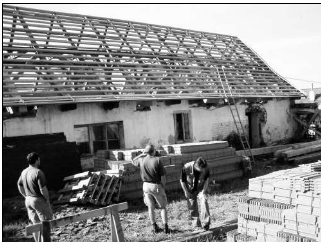
Objekt budoucí stanice pro handicapované živočichy při Zoo - Rozova u Temelína - dostal novou střechu
